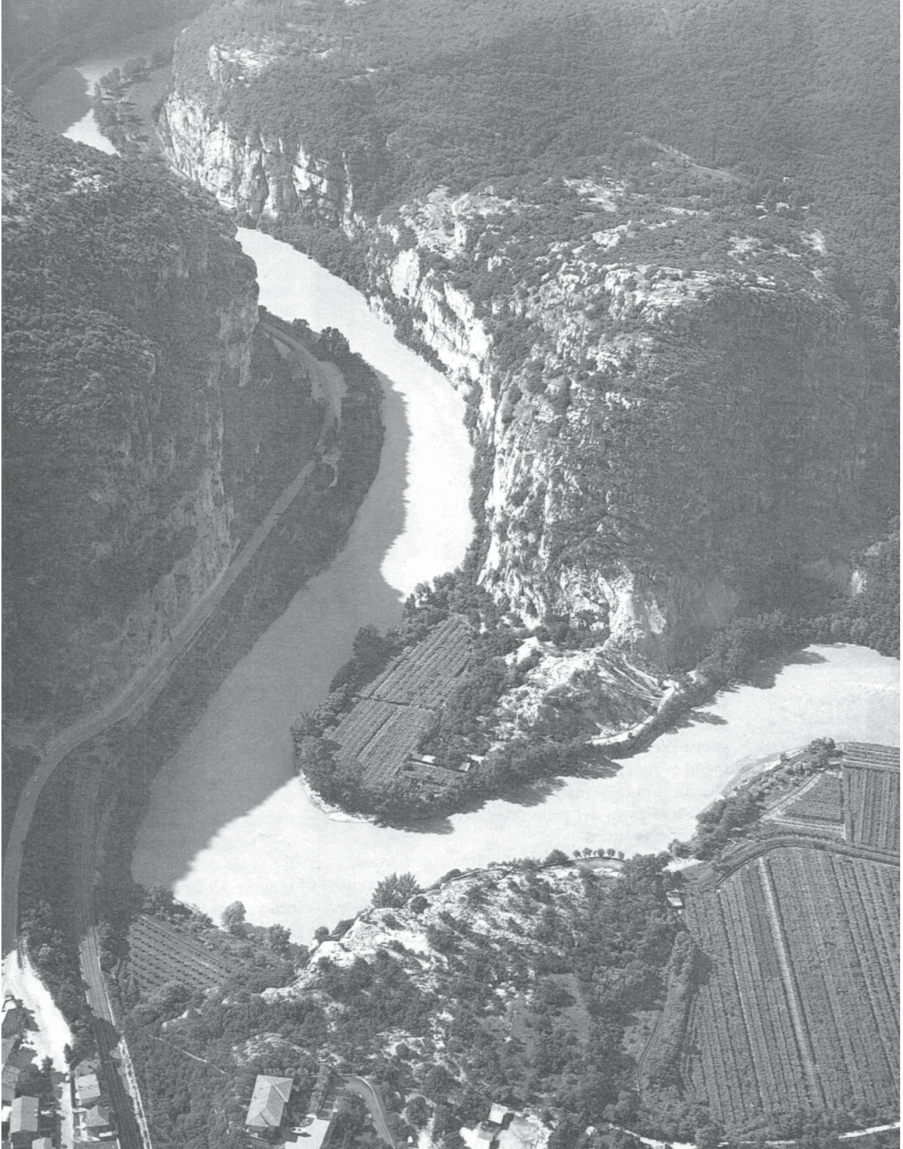
La chiusa di Rivoli-Ceraino (tratto da: Etsch-Adige "Il fiume, gli uomini, la storia", Cierre Edizioni, 1992).
