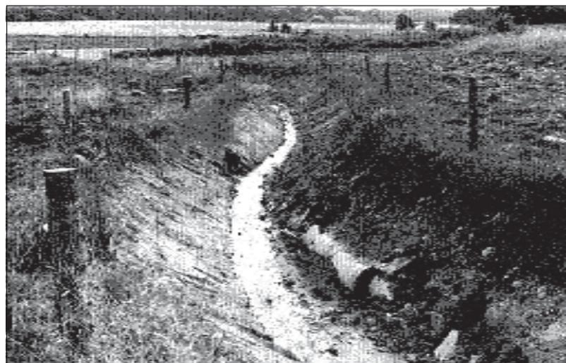
Fig. 54. Il canale Enggård Bæk (Danimarca), in passato intubato, viene riportato a cielo aperto, con un tracciato sinuoso. [da DANISH ENVIR. PROTECTION AGENCY, 1995]
