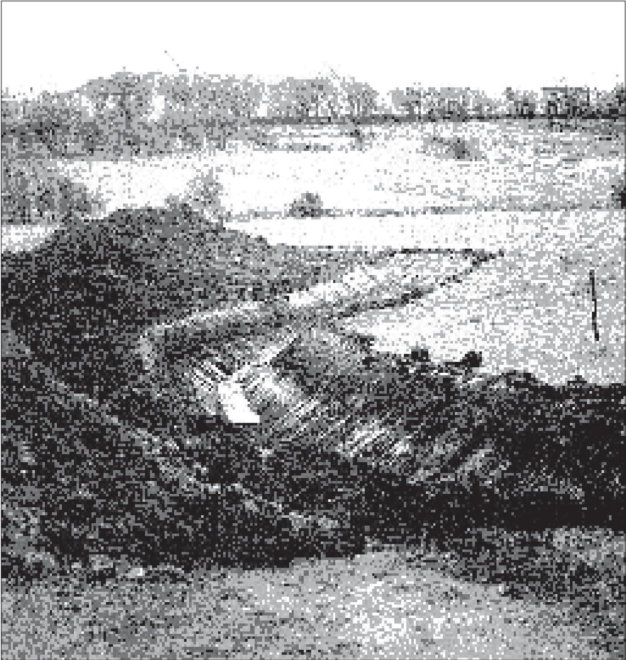
*Fig. 55. Scavo di un fosso meandriforme lungo il tracciato del canale Isholm Landgrøft (Danimarca), precedentemente tombato.
