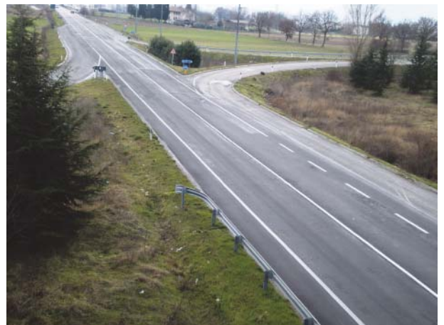
Fig. 6. Esempio di carreggiata pavimentata (SS 219 di Gubbio e Pian d'Assino).
