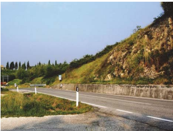
Fig. 5. Esempio di carreggiata in semitrincea (SS 298 Eugubina).
