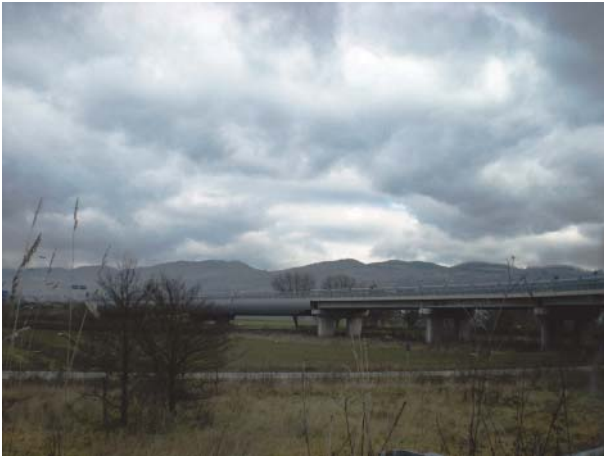
Fig. 3. Esempio di carreggiata su viadotto (SS 219 di Gubbio e Pian d'Assino).
