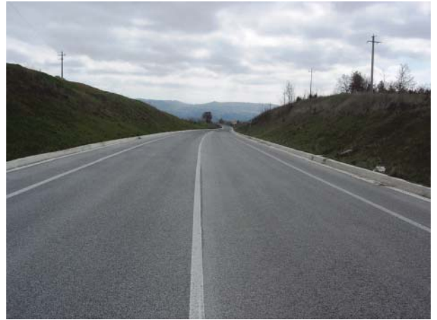
Fig. 4. Esempio di carreggiata in trincea (SS 219 di Gubbio e Pian d'Assino).
