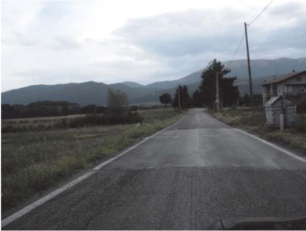
Fig. 1. Esempio di carreggiata a raso (Strada per Rancolfo).
