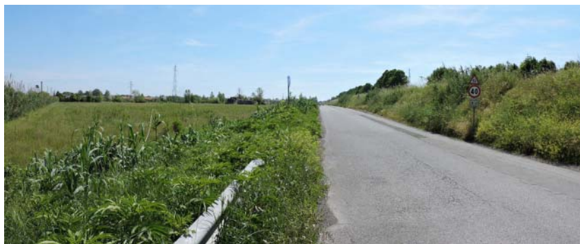
Fig. 3. Area circostante la sponda sinistra del fiume di Camaioere allo stato attuale. Anche questo tratto, secondo il progetto, dovrà essere adeguato alla piena duecentennale. Notare gli ampi spazi ancora incolti.
