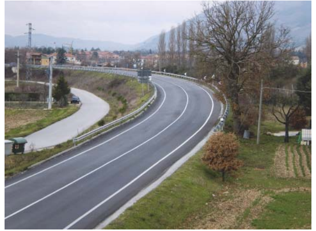
Fig. 2. Esempio di carreggiata in rilevato (SS 219 di Gubbio e Pian d'Assino).
