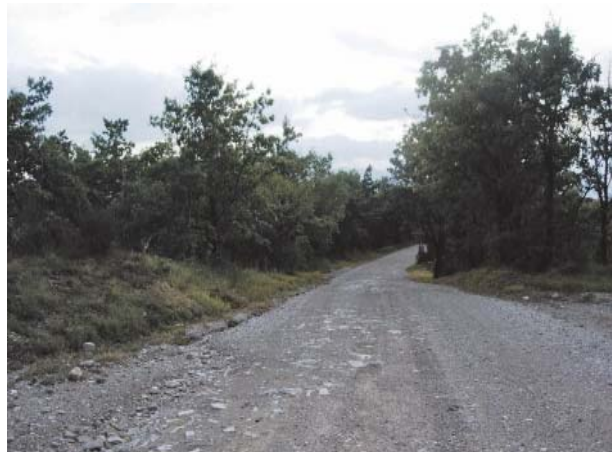
Fig. 7. Esempio di carreggiata non pavimentata (Strada Frontile Tegolaro).
