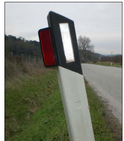
Fig. 2. Particolare di paracarro riflettente con segnalatore aggiuntivo catadiottrico per i grossi ungulati.
