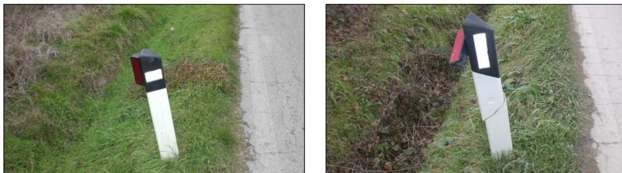
Fig. 3. Dissuasore del tipo a catadiottro montato lateralmente su segnalazione stradale preesistente. Il progetto, ancora in fase di studio, mostra già alcuni punti perfezionabili. Urti, manutenzioni inadeguate, avverse condizioni ambientali fanno ruotare la parte riflettente (foto a destra) rendendo inutile il dispositivo
