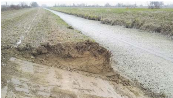
Fig. 6. Collettore Alfiere nel Tratto 2 durante i lavori. Riprofilatura della sponda al fine di garantire una pendenza della scarpata non superiore a 1:2 e favorire così la colonizzazione di specie elofitiche.
