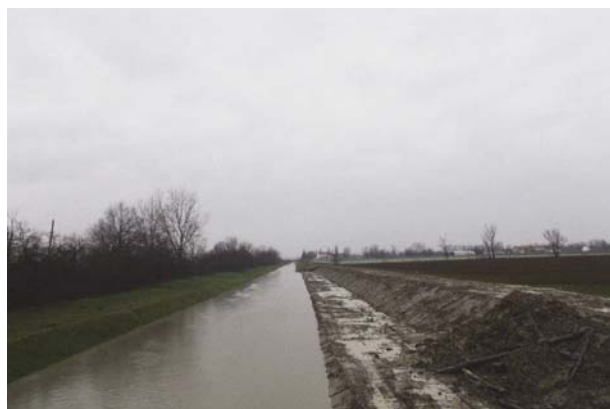
Fig. 8. A sinistra : CABM – Tratto 1 - Post piena del 10 febbraio 2016: la golenia scavata è stata allagata dalla prima piena. Ancora la vegetazione non si è sviluppata. Si noti la banchina sul lato opposto non interessata dalla piena a causa dell'altezza superiore alla golenia ribassata. A destra : CABM nel tratto 1 il 06/09/2016, a 7 mesi dal termine dei lavori: si noti la colonizzazione da parte della vegetazione elofitica.
