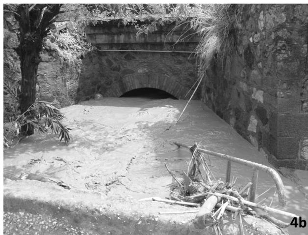
**Fig. 4.** Esempi di sottopassi alla linea stradale (4a) e ferroviaria (4b), occlusi dall'ingente trasporto di materiale solido, principalmente vegetale.
