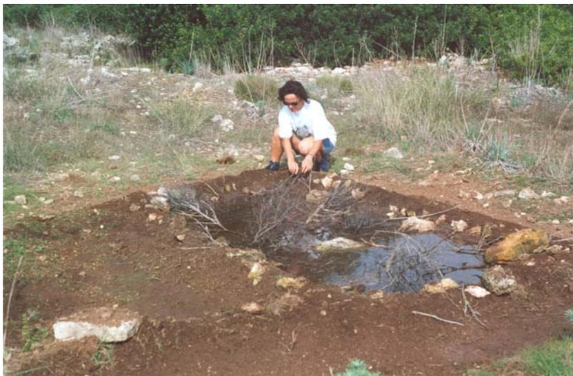
Fig. 6. Il sito di abbeverata è quasi pronto. Il film di polietilene è stato ricoperto da un sottile strato di terreno per mascherarne l'artificialità.
