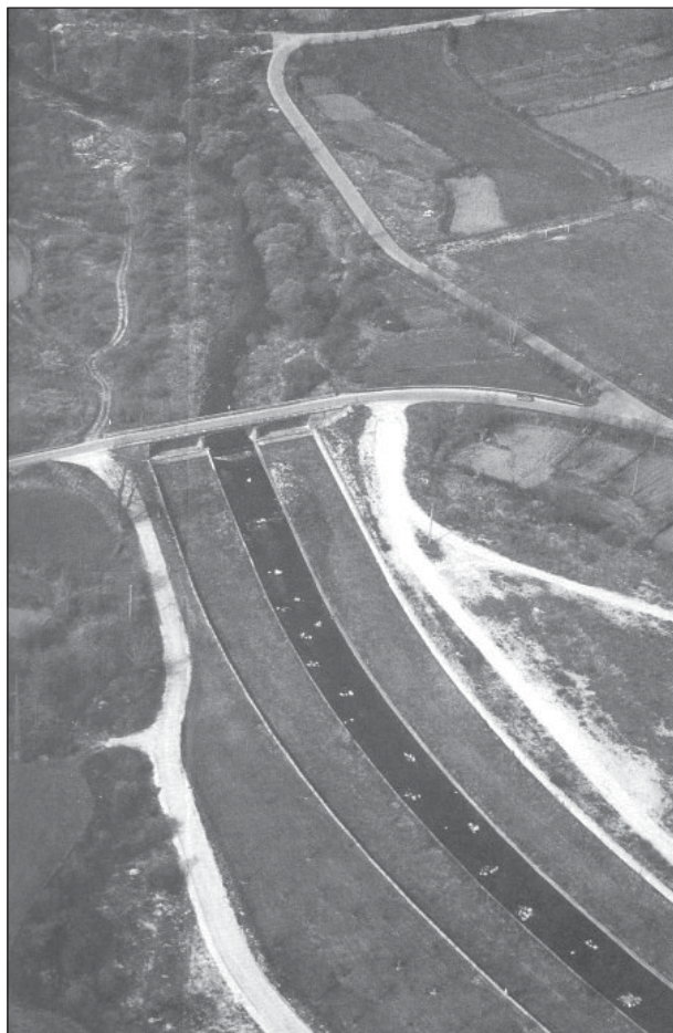
Fig. 3. Il fiume Sangro prima e dopo la "cura": il ponte evidenzia il confine tra lo stato naturale (in alto) e gli interventi di sistemazione idraulica con muri in calcestruzzo (in basso). (Foto tratta da una pubblicazione del WWF Italia).
