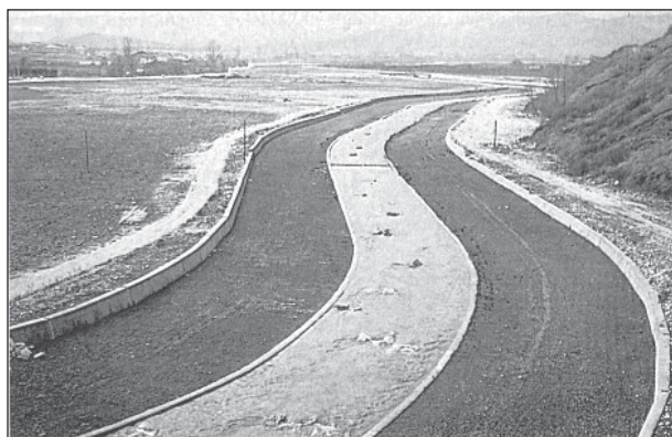
Fig. 2. Aspetto della canalizzazione del fiume Sangro al termine della sua realizzazione (1984).
