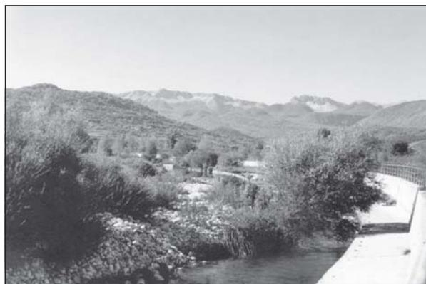
Fig. 14. Comunità vegetali e barre di sedimentazione all'interno della sezione artificiale in calcestruzzo
