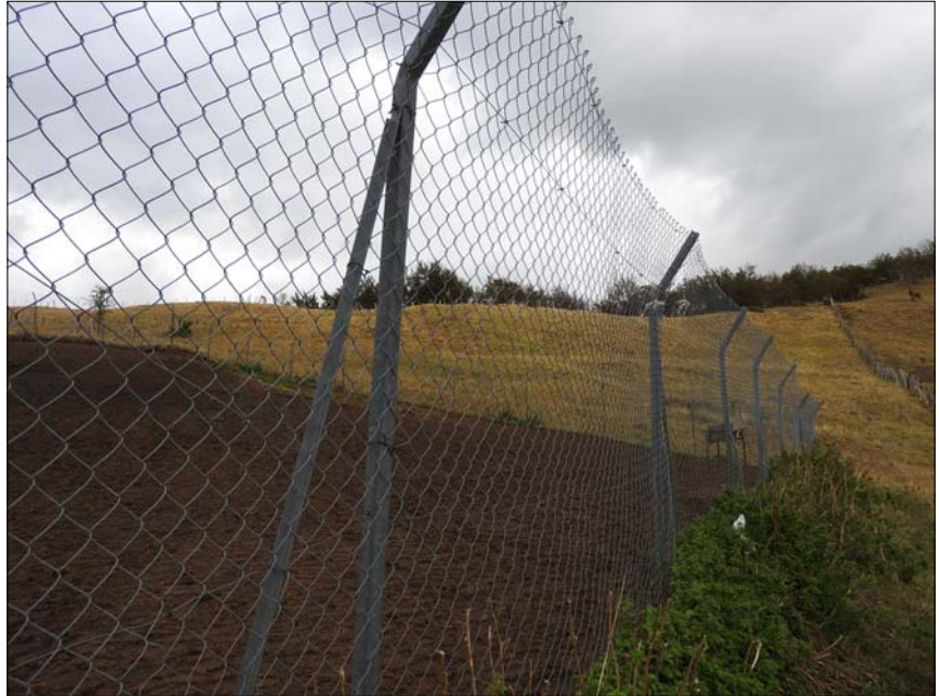
Fig. 2. Recinzione con caratteristiche simili alla figura 1 ma con dispositivo “antigatto” in alto. Parco Nazionale dell’Appennino tosco-emiliano.
