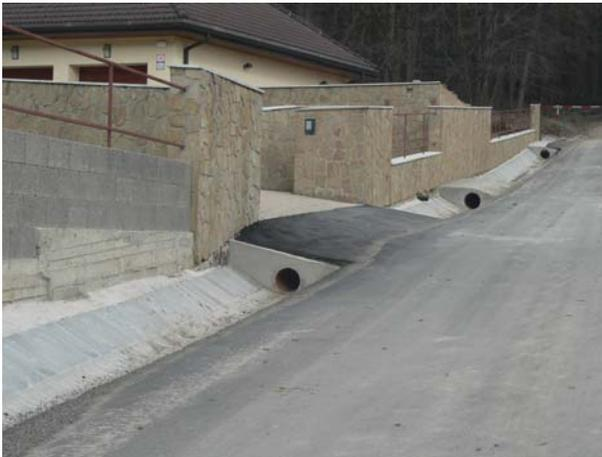
**Fig. 15.** Una strada asfaltata e un canale di scolo perfettamente pavimentato in ambiente urbano. Alcune soluzioni non consentono nemmeno alla più piccola quantità di acqua di infiltrarsi nel terreno.
