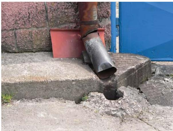
**Fig. 13.** Il rapido allontanamento delle acque piovane. L'obiettivo originale dei proprietari era quello di ottenere "asciutto e calore". Il perseguimento di questo obiettivo sta cominciando a sfuggire al controllo.
