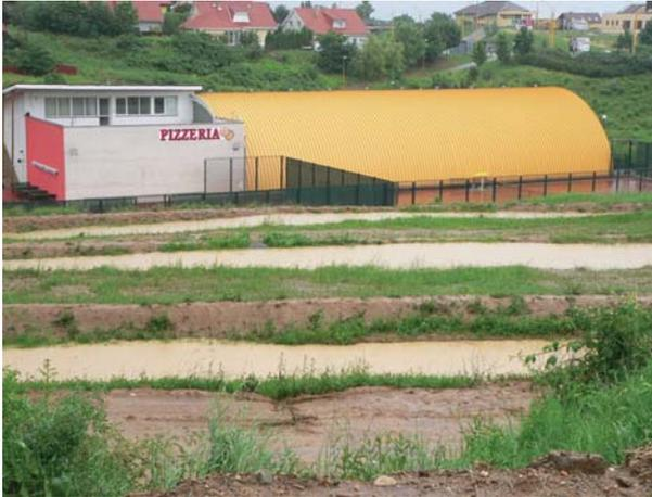
**Fig. 36.** Il complesso residenziale KVP a Košice: protezione degli edifici posti ai piedi di un pendio, grazie a bacini di ritenzione (fossi orizzontali, disposti lungo le curve di livello).
