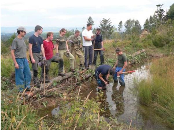
**Fig. 35.** Una zona umida artificiale negli Alti Tatra: realizzazione di un sistema di conservazione dell'acqua sul territorio distrutto da un disastro naturale. Esempio di ripristino della vegetazione e di stabilizzazione idrologica di un'area attraverso la conservazione dell'acqua nel suolo.
