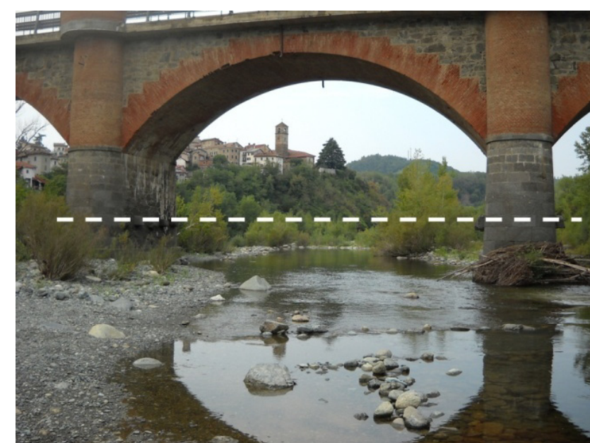
Tratto 4: ponte SS456 - Molare (la linea bianca tratteggiata indica la quota del fondo dell'alveo negli anni '40).
