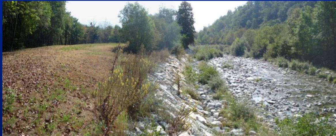
PORZIONE MONTANA: alveo in generale con sezione integra; si evidenziano però localizzati interventi di artificializzazione: soglie, briglie e muri spondali, soprattutto in corrispondenza di centri abitati come Crissolo.
