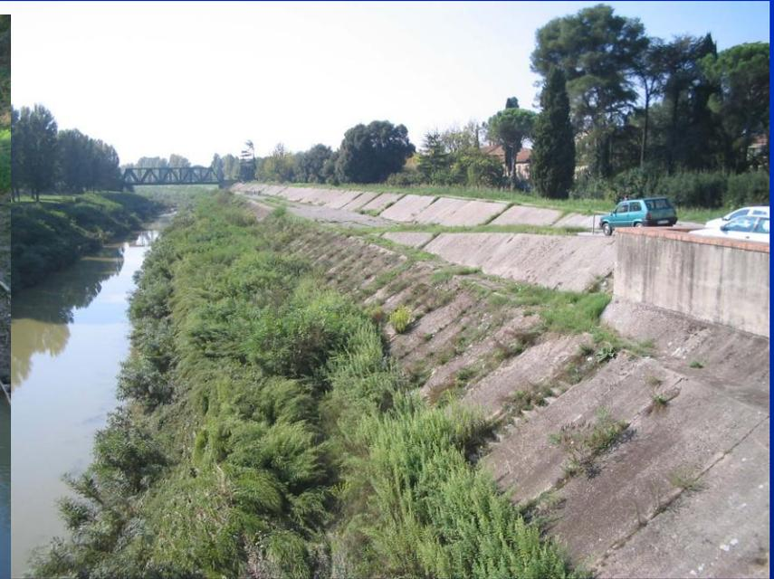
I **fenomeni erosivi** sono frequenti in tutta l'asta fluviale: spesso sono mitigati e nascosti dalla presenza di interventi artificiali mentre altre volte sono evidenti con scavo delle rive e delle radici, talora limitati alle curve e strettoie.
